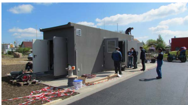
Slika 11: Izvedba strojnih in elektro instalacij (povezav) v objektu
