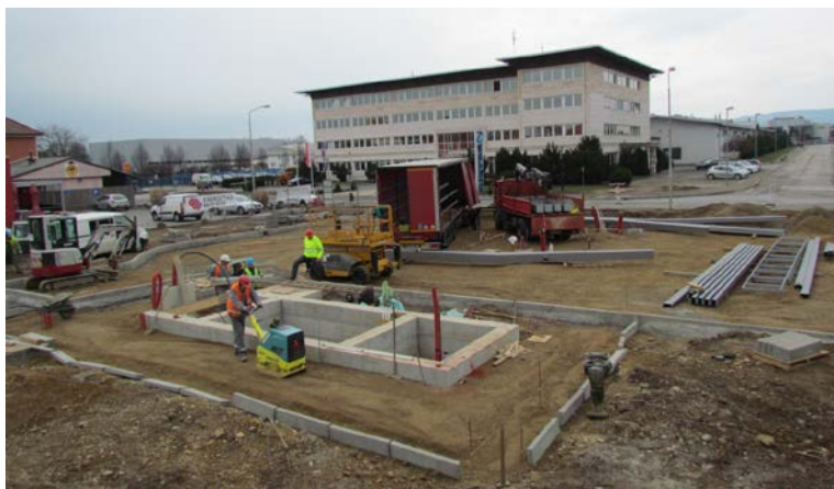
Slika 9: Izgradnja temeljev kontejnerske enote, polaganje cestnih robnikov in priprava planuma, montaža jeklene konstrukcije nadstreška
