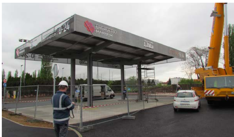
Slika 10: Montaža napisov na atiki nadstreška, raztovor kontejnerske enote
